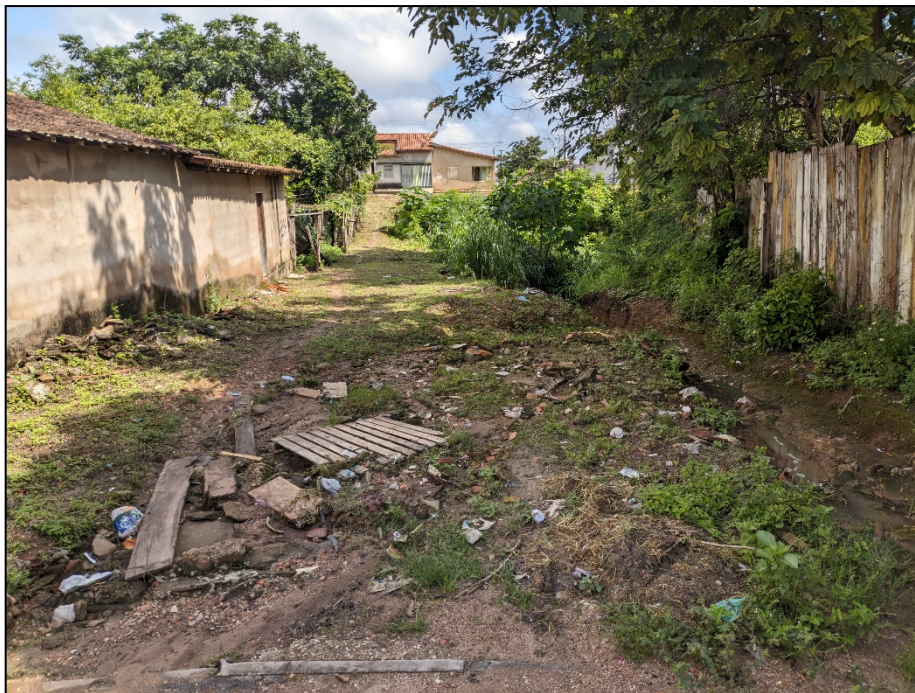
Imagem 2: Trecho da R. Piauí, erosão profunda. (utilizado para descarte indevido de lixo)
